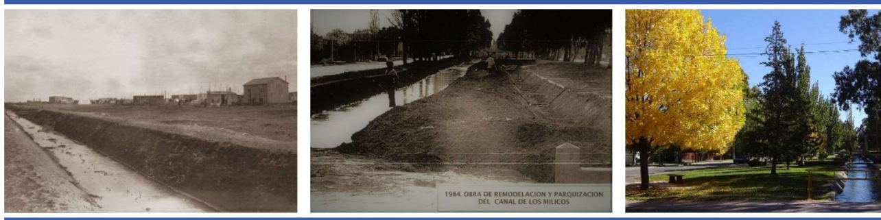
Fig.2 Imágenes, desde la construcción del “Canal de los Milicos” al “paseo del Canalito”
